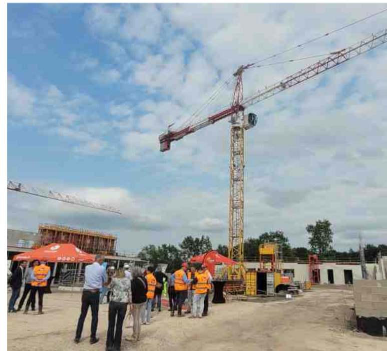
Les travaux de gros œuvre par le groupe GBMP sont en cours sur le terrain de 8,44 hectares. O. D.
