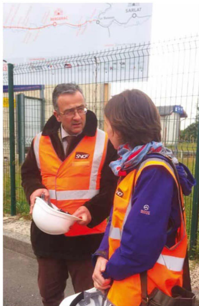
Visite de chantier : la rénovation de la ligne de TER.
